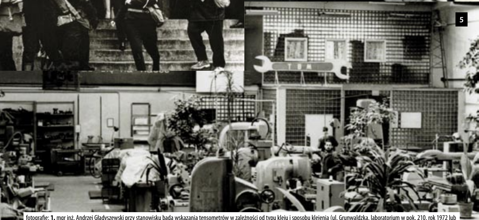
fotografie: 1. mgr inż. Andrzej Gładyszewski przy stanowisku bada wskazania tensometrów w zależności od typu kleju i sposobu klejenia (ul. Grunwaldzka, laboratorium w pok. 210, rok 1972 lub 1973) • 2. Rektor WSI prof. Tadeusz Bełdowski (z lewej) gości Rektora Akademii Medycznej w Białymstoku prof. Piotra Boronia (z prawej). Możliwości nowoczesnej maszyny cyfrowej ODR 1204 omawia mgr Jan Leszczyński (ul. Grunwaldzka, sala 209, 1971 r.) • 3. Sanitariuszki – pracownice WSI wybiegają z budynku przy ul. Grunwaldzkiej 11/15 podczas ćwiczeń obrony cywilnej (lata 70.) • 4. Inauguracja Roku Akademickiego 1974/75. Przedstawiciel MNIŚW wręcza Rektorowi Bełdowskiemu akt nadania uczelni nazwy „Politechnika Białostocka” (październik 1974 r.) • 5. Hala Obrabiarek Wydziału Mechanicznego dobudowana do budynku na Grunwaldzkiej w 1964r. Wśród obrabiarek było tu wiele roślin, a nawet klatki z ptaszkami (1975 r.)
