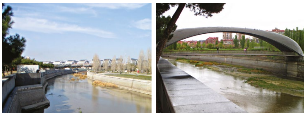
FIG. 4.9. Nuevos puentes y pasarelas peatonales del río Manzanares, en Madrid, España. Izquierda: Puente diseñado por D. Perrault. Derecha: Puente con mosaicos en Matadero (Fuente: M. A. Flórez de la Colina, 2019)
