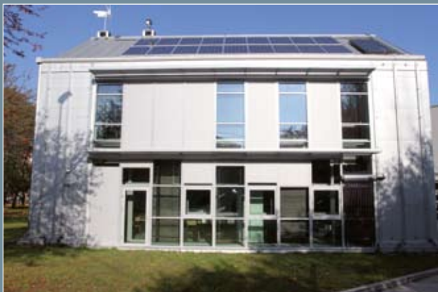
Budynek laboratoryjno-badawczy Wydziału Architektury
