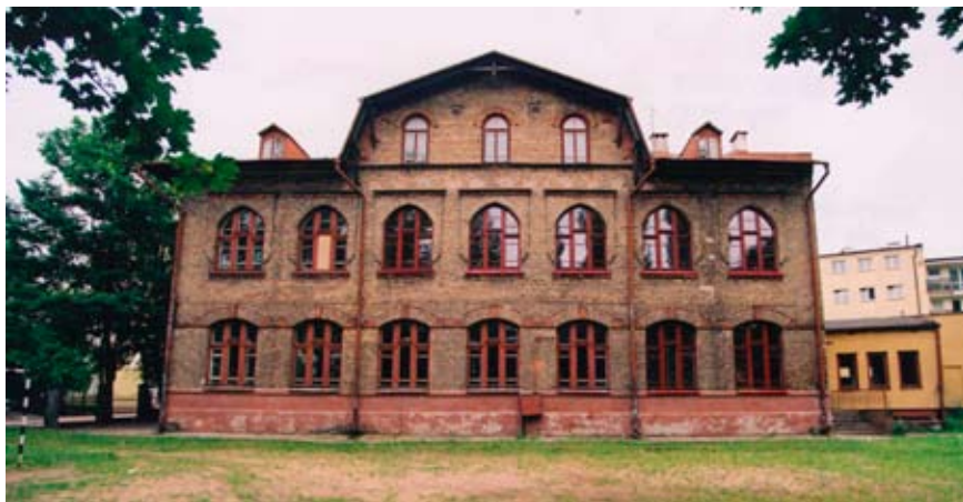
Budynek przedwojennego Żydowskiego Gimnazjum Hebrajskiego przy ul. Lipowej 41D
