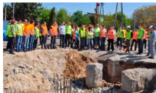
9 maja 2012, wycieczka członków Koła Zakładowego SITK RP przy PB na budowę Południowej Obwodnicy Warszawy w ciągu drogi ekspresowej S2, fot. M. Motylewicz
