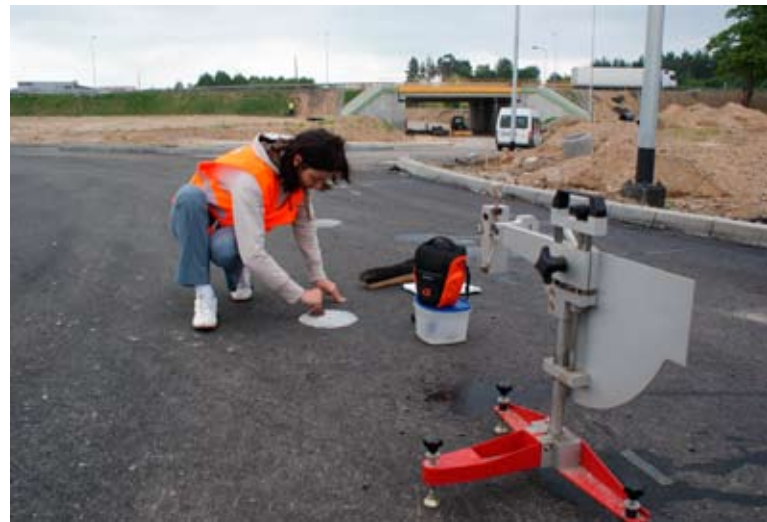
fot. 2. Pomiar makrotekstury nawierzchni drogowej
