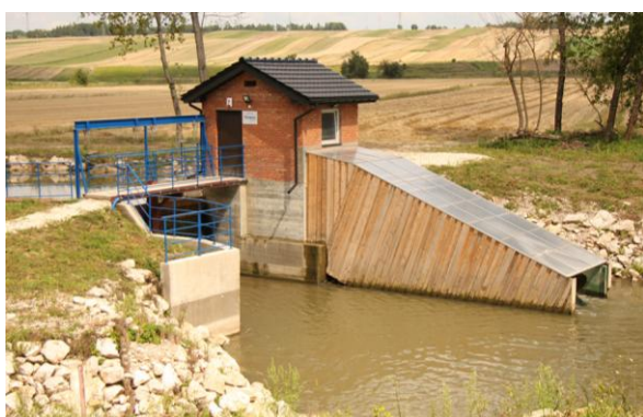
Rys. 7. Mała elektrownia wodna
