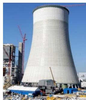
Rys. 5. Budowa chłodni kominowej w elektrowni Jaworzno III. Źródło: [4]
