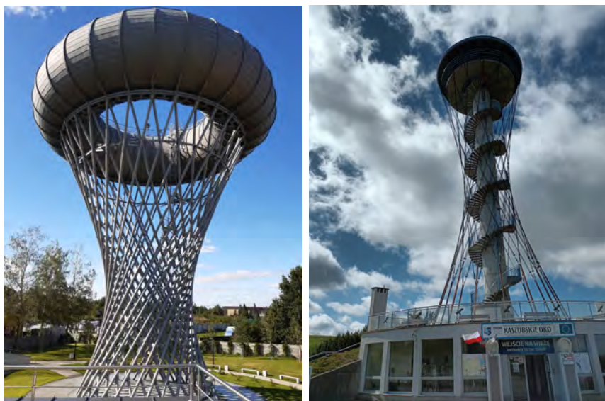
Rysunek 5.6: Wieża ciśnień w Ciechanowie jako element Parku Nauki TORUS – hiperboloida jako konstrukcja nośna, zbiornik w kształcie torusa, fot. B. Koźniewski; „Kaszubskie oko” – trzy powierzchnie: walec jako konstrukcja nośna, schody jako helikoida oraz hiperboloida obrotowa jako struktura stężająca, fot. W. Reglińska
