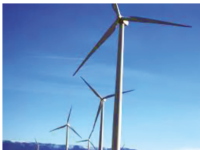
RYS. 14. Turbina wiatrowa pozioma trzyłopatowa
