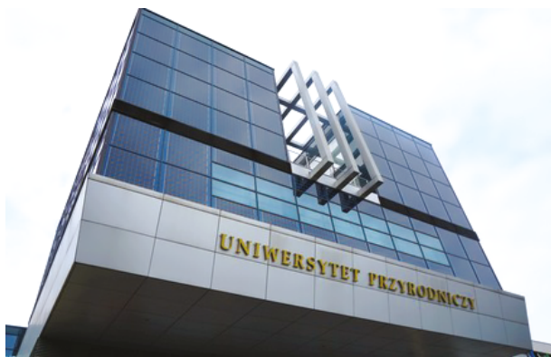
RYS. 9. Ognia fotowoltaiczne na fasadzie budynku
