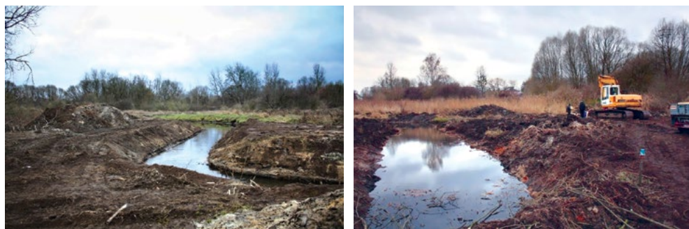
Rysunek 11. Rzeka Biała w trakcie meandryzacji a) teren pierwotny b) przebudowa
