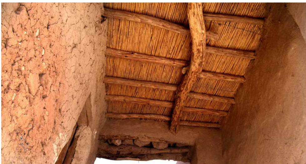
Ryc. 9. Trzcinowy strop pustynnego ksaru w Ait Ben Haddou; fot. autor, 2010
