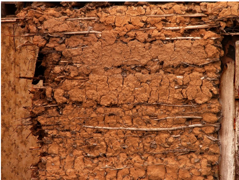
Ryc. 50. Ściana glinobita gęsto zbrojona chrustem jałowcowym (wieś Zalesie w gminie Wysзки na Białostocczyźnie); fot. autor, 2008
