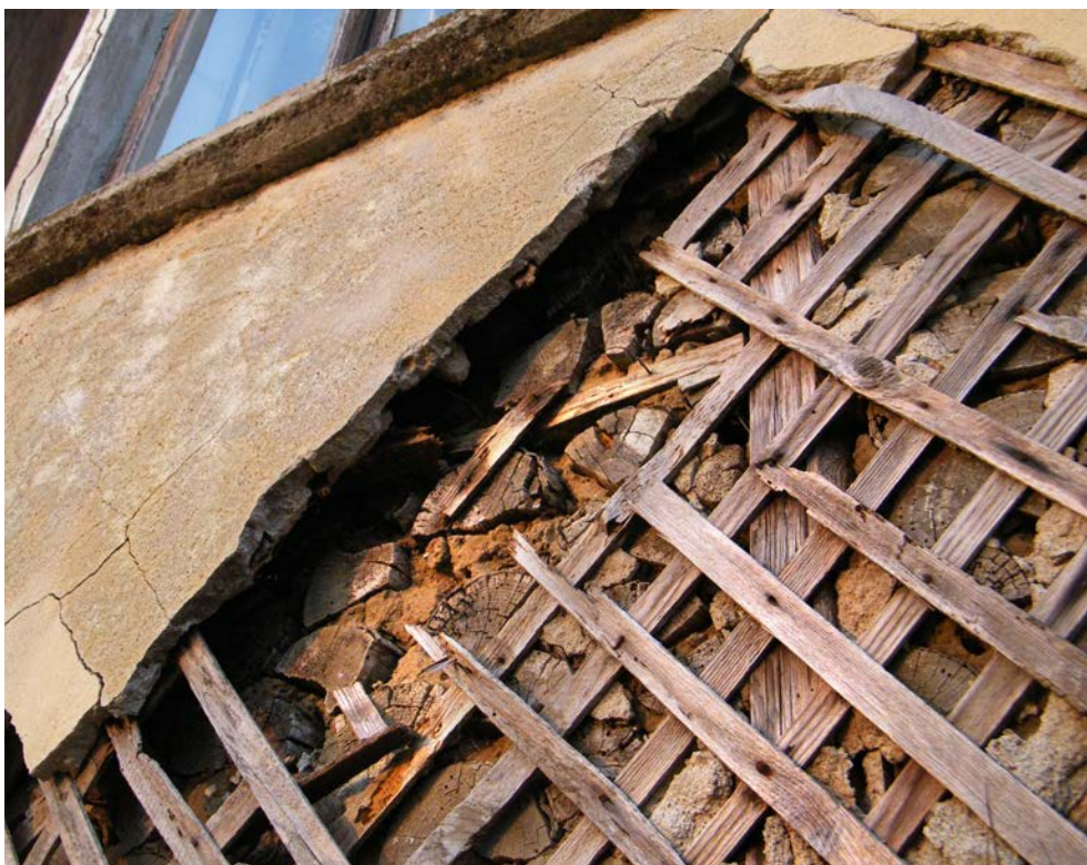
Ryc. 48. Dewnniane listwowanie ściany szkieletowo-glinopolanowej; fot. autor, 2010
