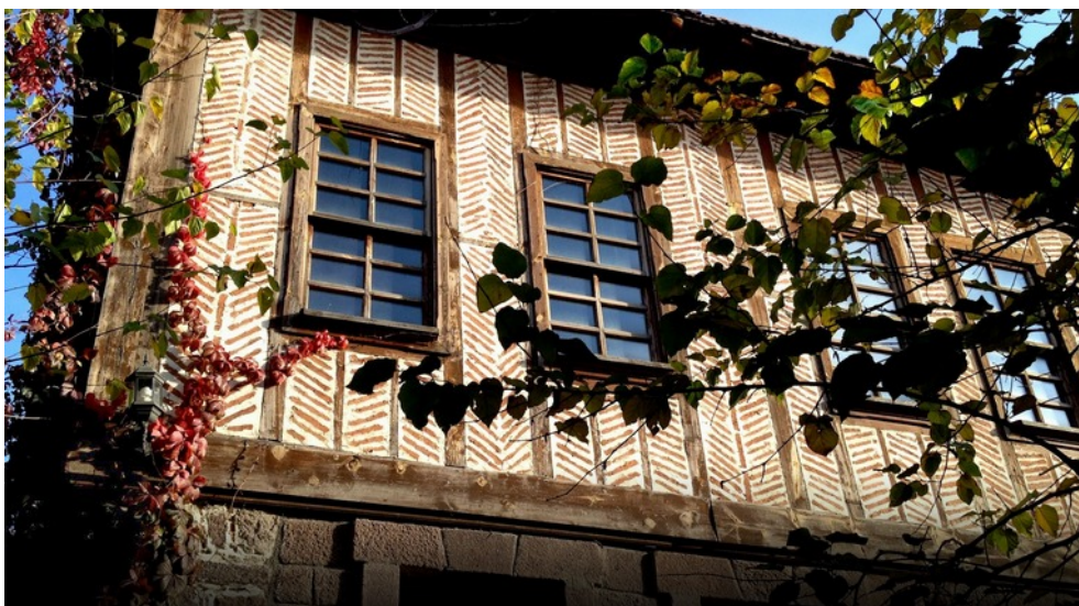
Ryc. 31. Ściana starego domu w Ankarze w środkowej Turcji o konstrukcji typu hımış z wypełnieniem ceglanym; źródło: Wikimedia Commons ( https://commons.wikimedia.org/wiki/File:Old_Turkish_Houses_Ankara.jpg , na licencji CC-SA 4.0, fot. użytkownik Pivox, 2017)
