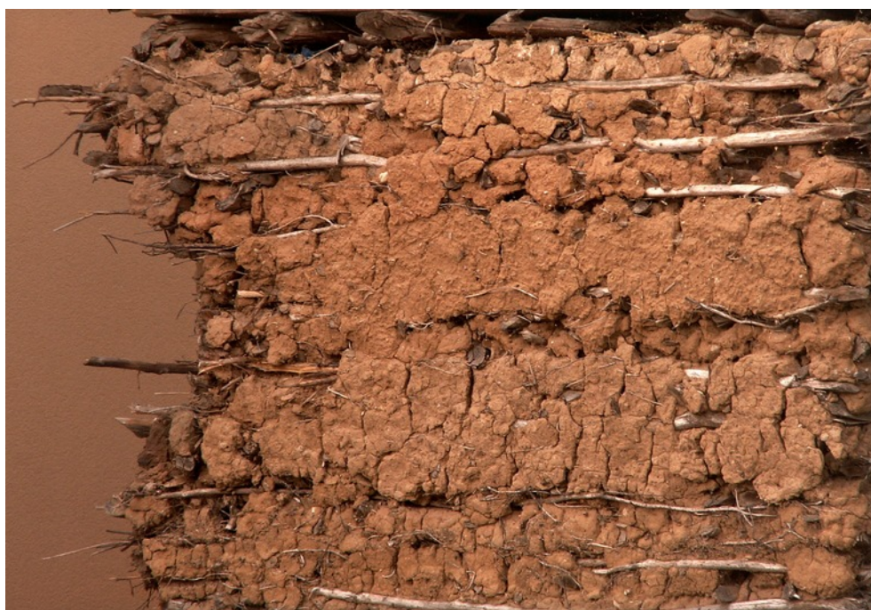
Ryc. 56 i 57. Glinojalowcowa ściana domu w Zalesiu w gminie Wyszki na Białostocczyźnie, wzniesionego około 1950 roku; fot. autor, 2008
