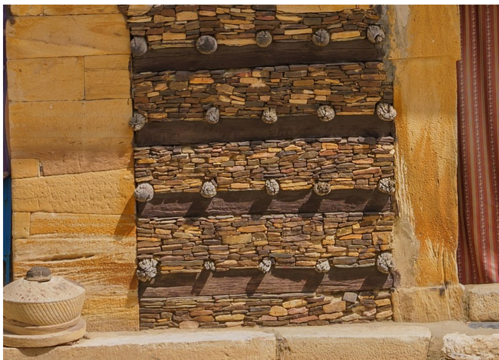
Ryc. 19. Powiększenie konstrukcji kamiennych ścian z drewnianymi wzmocnieniami w kościele przyklasztornym na górze Debre Damo w Etiopii (fragment ilustracji 18)
