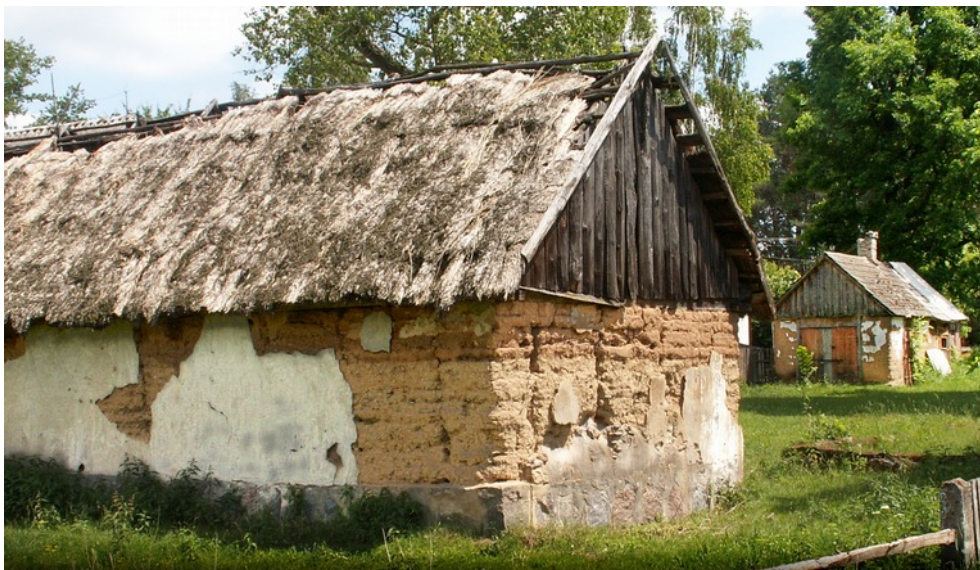
Ryc. 5. Pochodzące z połowy XX wieku budynki z gliny zbrojonej jałowcem we wsi Tworkowice koło Ciechanowca na Białostocczyźnie; fot. autor, 2009
