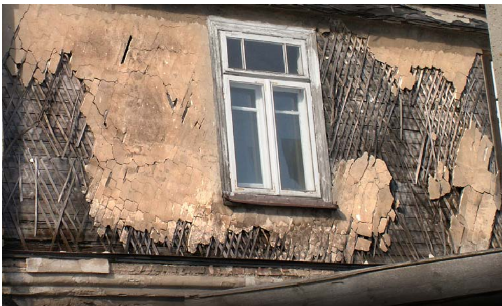
Ryc. 45. Drewniane listwowanie podtynekowe nałóżone na warstwę poziomego szalowania zrębowej ściany budynku w centrum Białegostoku; fot. autor, 2006
