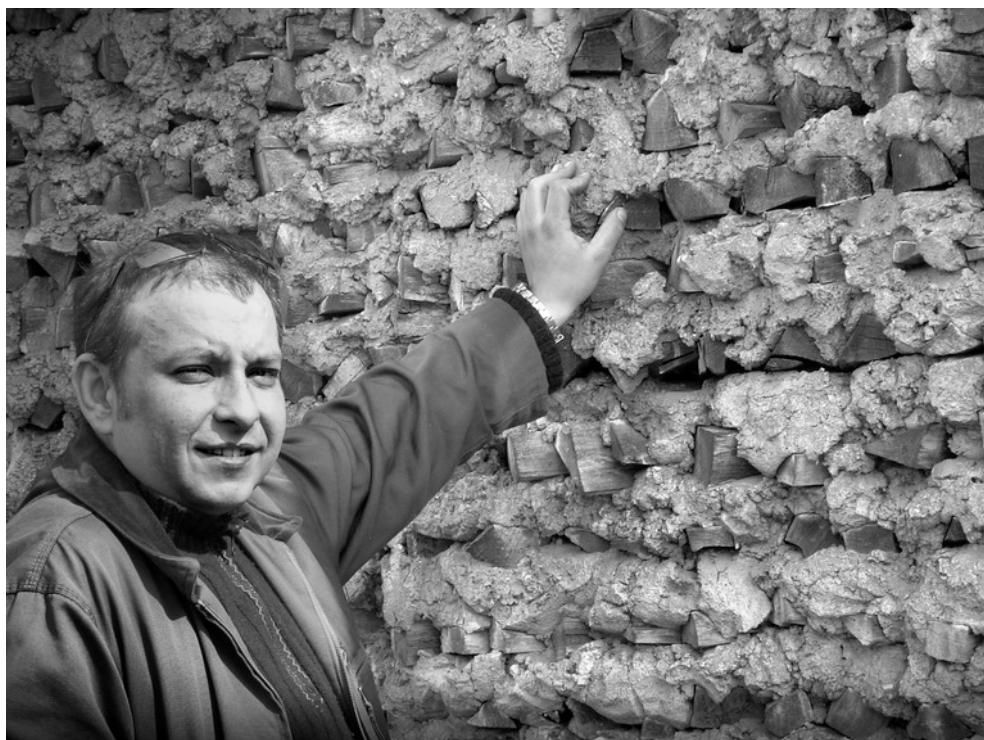
Ryc. 67. Drewnobetonowa ściana domu w Mężeninie; fot. autor, 2008
