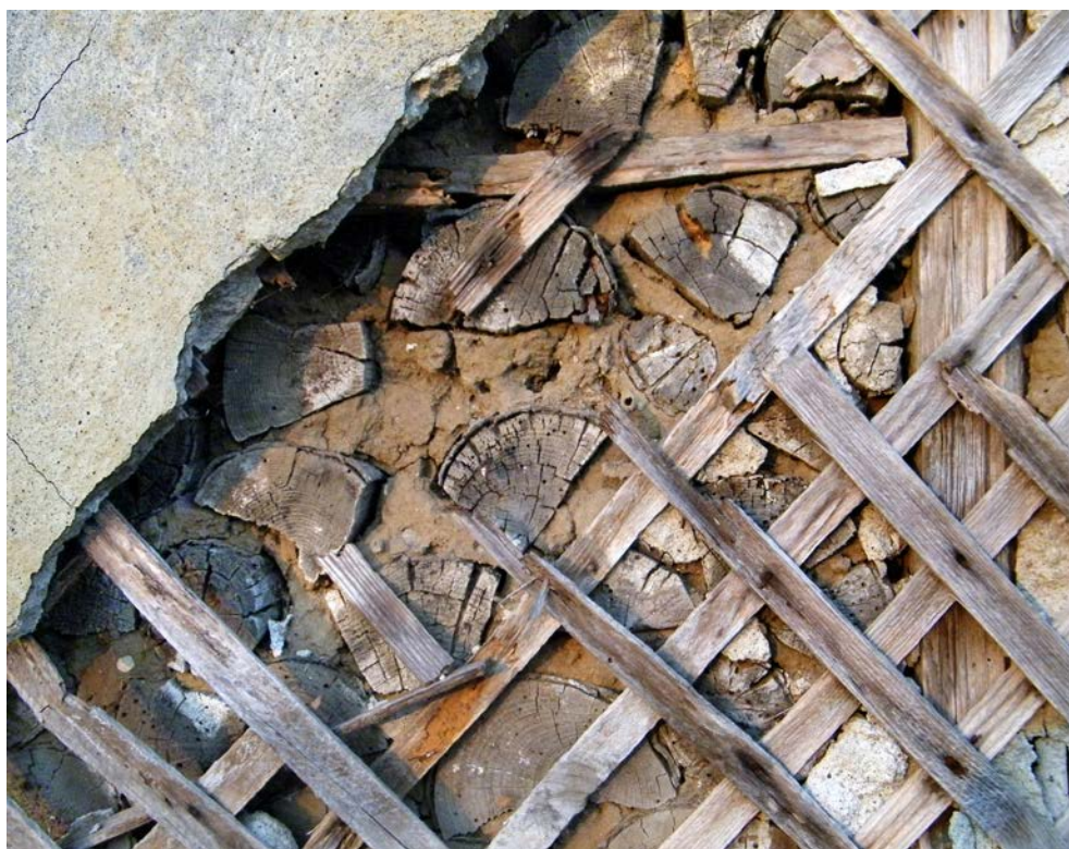
Ryc. 49. Drewniane listwowanie ściany szkieletowo-glinopolanowej; fot. autor, 2010
