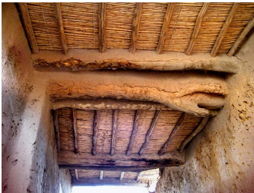
Ryc. 8. Trzinowe maty nakrywające strop korytarza pustynnego ksaru w marokańskim Ait Ben Haddou, będące tam również zbrojeniem stropów międzykondygnacyjnych; fot. autor, 2010
