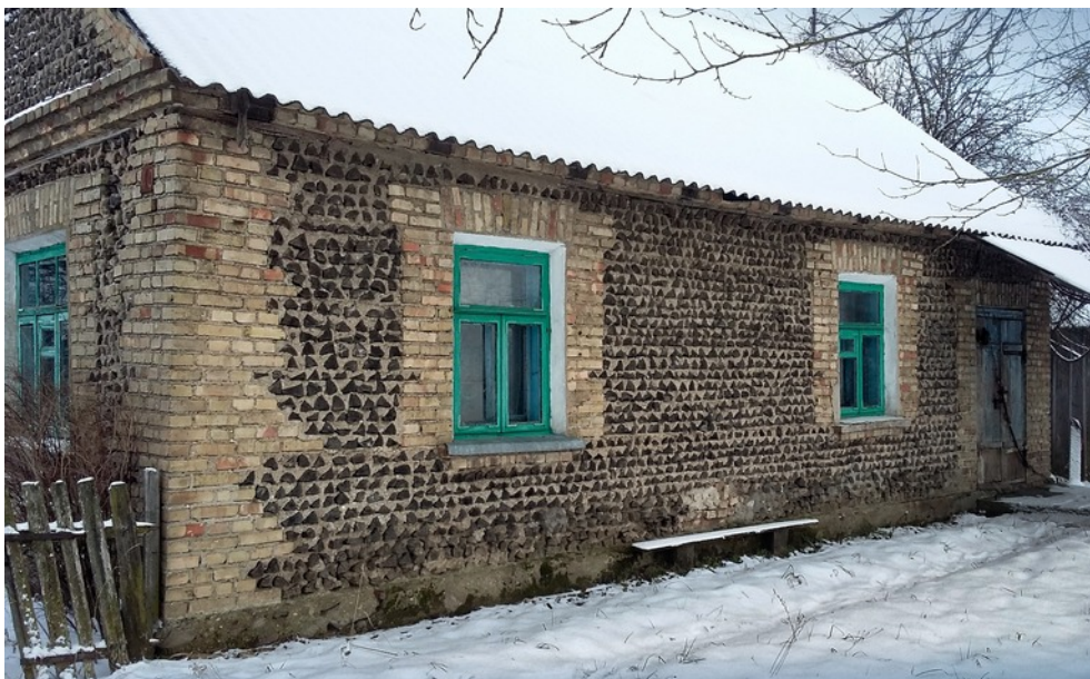
Ryc. 58. Dom w białoruskiej wsi Strubnica mający zasadę konstrukcyjną podobną jak w budynkach stawianych według zaleceń Hundta, w tym ceglane zabezpieczenia naroży, zaś ściany z drewna spajanego zaprawą; fot. Julia Mazets, 2016 (z archiwum Wydziału Architektury Politechniki Białostockiej)
