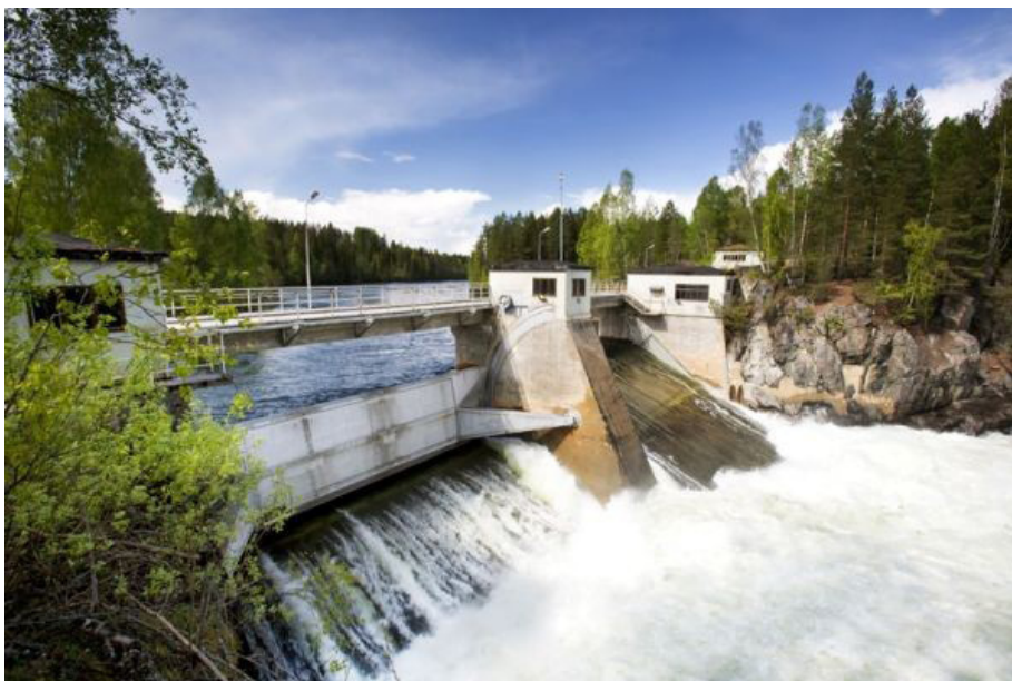
Rys. 2.1. Zapora elektrowni wodnej [6]
