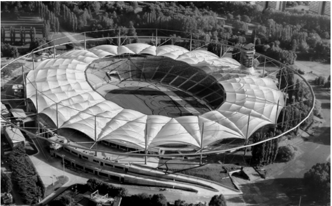
Fot. 1-40. Stadion Śląski – widok ogólny projektu zadania SATURN 2005. Konstrukcję wsporczą stanowi zespół dwudziestu słupów, w rozstawie co dwa sektory widowni. Poszycie połaci dachowej zaprojektowano z częściowo przezroczystej membrany PTFE, a w rejonie wieży z całkowicie przezroczystej membrany ETFE. Membrana rozpięta jest na łukowych wręgach stalowych, te z kolei wsparte są na dolnych cięgnach dźwigarów kablowych. Napięcie dźwigarów kablowych zapewniane jest dzięki sprężonemu pierścieniowi wewnętrznemu i sztywnemu pierścieniowi zewnętrznemu, stabilizowanemu za pomocą odciągów. Wizualizacja: M. Morga, archiwum ZPiW-TB.
