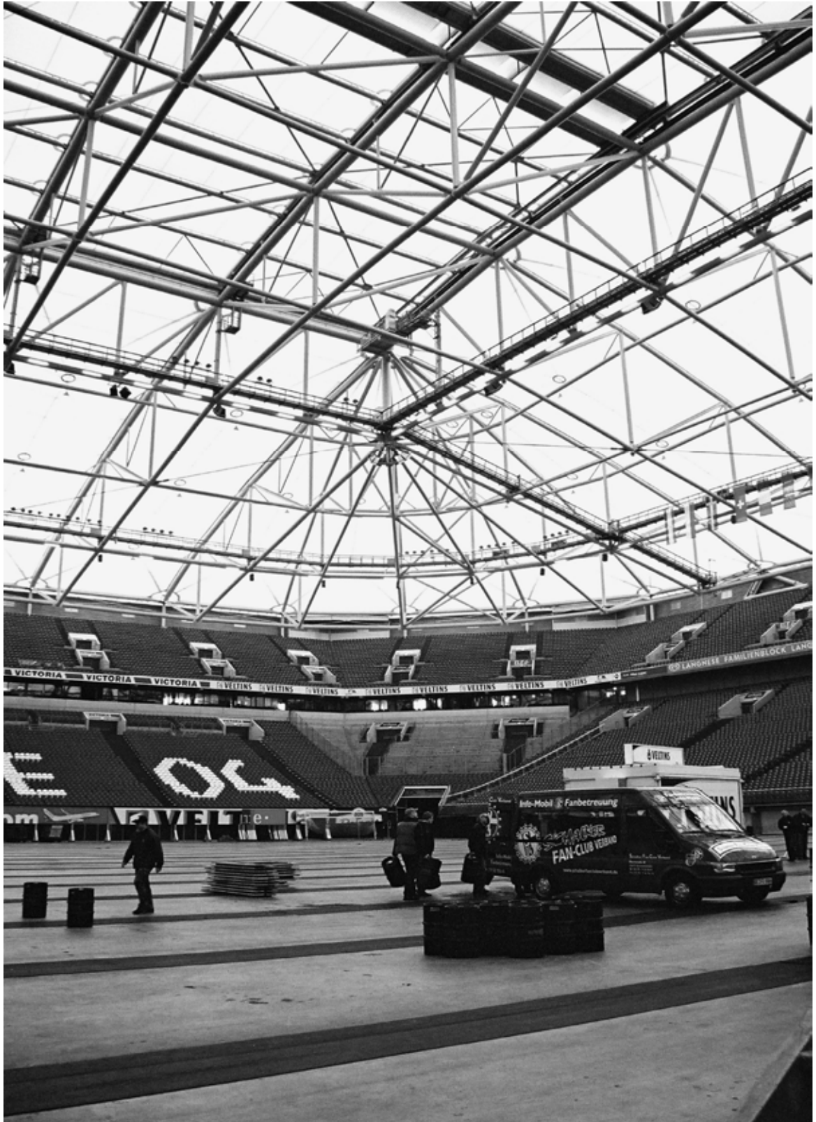
Fot. 1-17. Veltins Arena, Gelsenkirchen. Stadion całkowicie zadaszony, z klapowym systemem otwierania dachu nad areną. Membranowe poszycie połaci dachowej wykonano z tkaniny technicznej z osnową z włókna szklanego, pokrytego teflonem (PTFE). Stopień przezierności membrany dobrano na poziomie, który zapewnia wystarczającą ilość światła naturalnego we wnętrzu, nawet w pochmurne dni. Jest to światło rozproszone, dające efekt bezcieniowej, równomiernej iluminacji całego wnętrza. Na pierwszym planie widoczna betonowa posadzka areny z pasami jezdnyymi wysuwanej platformy boiska z naturalną murawą.
