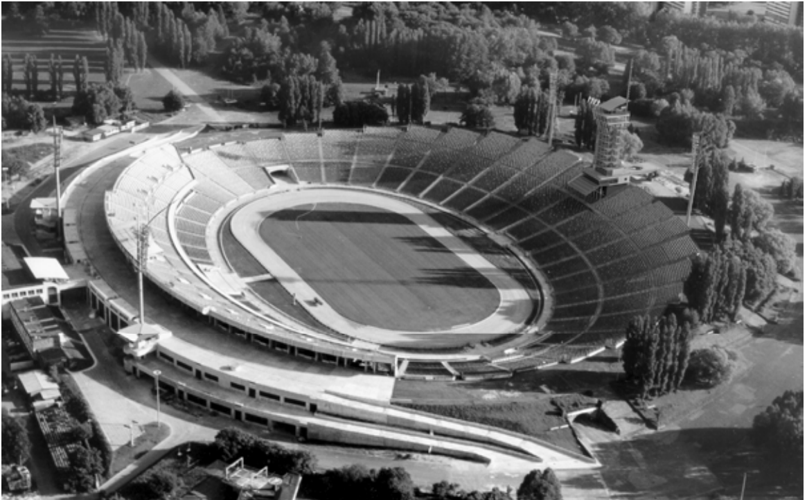
Fot. 1-39. Stadion Śląski – widok z lotu ptaka od strony północnej. W obrębie widowni zachodniej widoczny fotomontaż projektowanej przebudowy wieży dyspozytorskiej i masztów oświetleniowych, jako element analizy stanu przejściowego przed realizacją dachu. Foto: T. Najdzień, archiwum ZPiW-TB.
