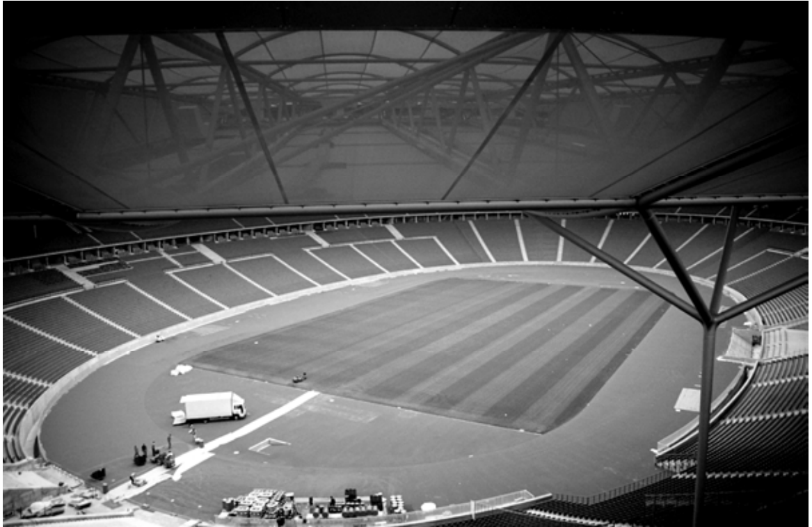
Fot. 4-8. Stadion Olimpijski w Berlinie w trakcie modernizacji (2005). Fragmenty widowni dolnej o krytycznie ekstensywnym układzie dróg komunikacyjno-ewakuacyjnych. Projekt: GMP Architekten.
