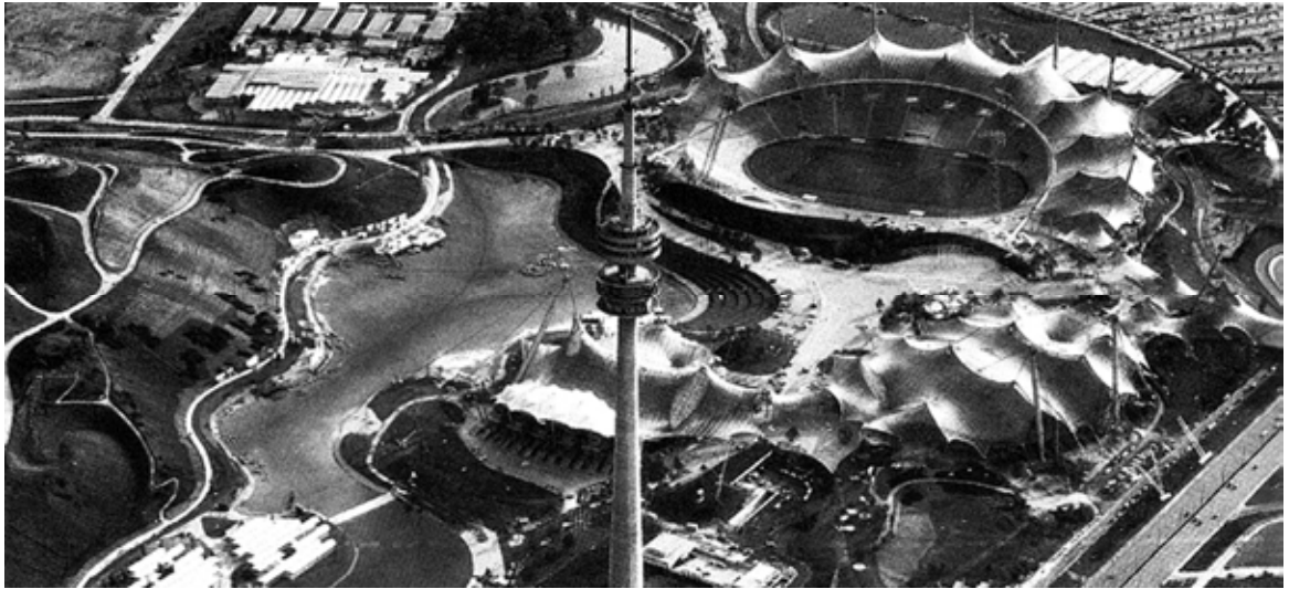
Fot. 1-11. Olimpiapark – kompleks obiektów XX Olimpiady w Monachium (1972). Rewolucyjne rozwiązanie architektoniczne, możliwe do zrealizowania dzięki wyprzedzającej epokę konstrukcji z zastosowaniem ciągnowych przekryć dachowych i całkowicie przeźroczystego poszycia.
