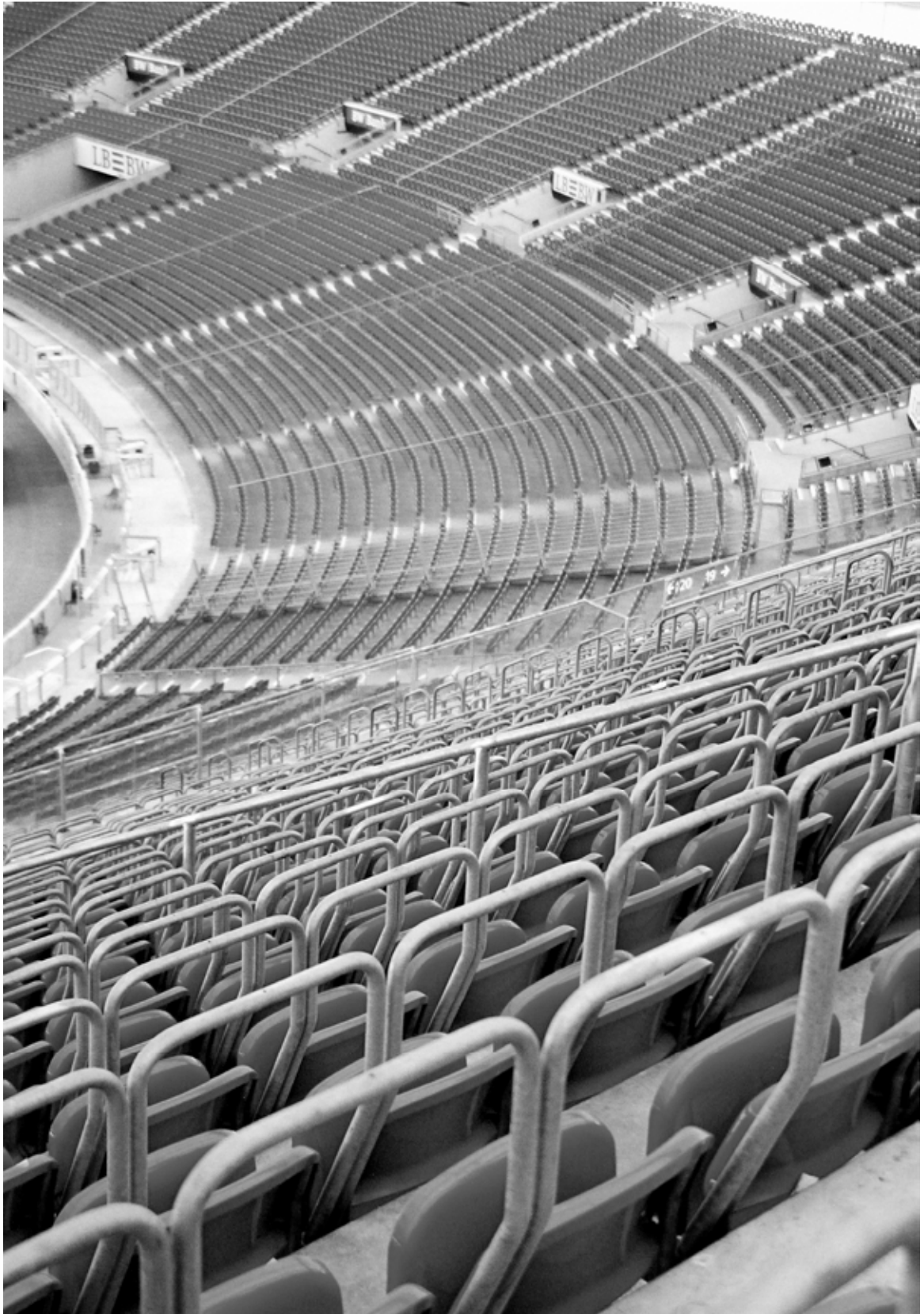
Fot. 2-5. Gottlieb Daimler Stadion , Stuttgart, (2005). Widownia łukowa o profilu prostoliniowym łamanym. Arena stadionu służy zawodom lekkoatletycznym i meczom piłkarskim. Widownia odzwierciedla kształt bieżni lekkoatletycznej – jej łuki na osi długiej stadionu zbliżone są do idealnie kołowych. Na pierwszym planie fragment nadbudowanej widowni zachodniej o nachyleniu 33^\circ z siedziskami, których konstrukcja oparcie wykształca równocześnie balustradę czołową rzędu.
