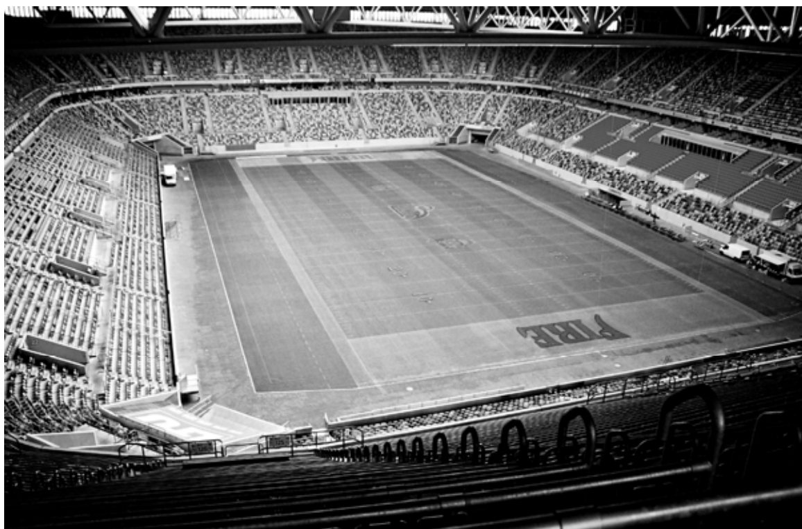
Fot. 2-4. Stadion LTU Arena , Düsseldorf, (2005). Przykład widowni prostokreślniej o profilu prostoliniowym. Linie rzędów widowni przebiegają równoległe do linii bocznych boiska. Ustalona pozycja siedzisk, oś anatomicznego pola widzenia jest prostopadła do zewnętrznych krawędzi pola gry. Obiekt należy do nielicznej grupy europejskich stadionów z otwieranym dachem nad areną. Foto: M. Pelczarski.
