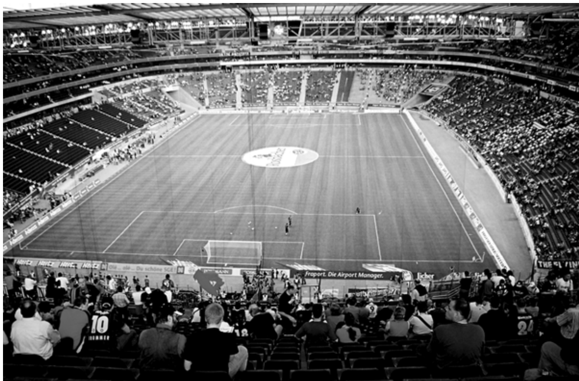
Fot. 2-3. Stadion Commerzbank Arena , Frankfurt, (2005). Przykład widowni łukowej o profilu prostoliniowym. Linie rzędów widowni przebiegają łukowo dzięki czemu, określona pozycja siedzisk, oś anatomicznego pola widzenia nakierowana jest dośrodkowo, wykazując konwergencję z osią obrazu pola boiska. Widownie łukowe mają pod tym względem przewagę nad widowniami prostokreślnymi, które cechuje dywergencja obu tych osi. Foto: autor.
