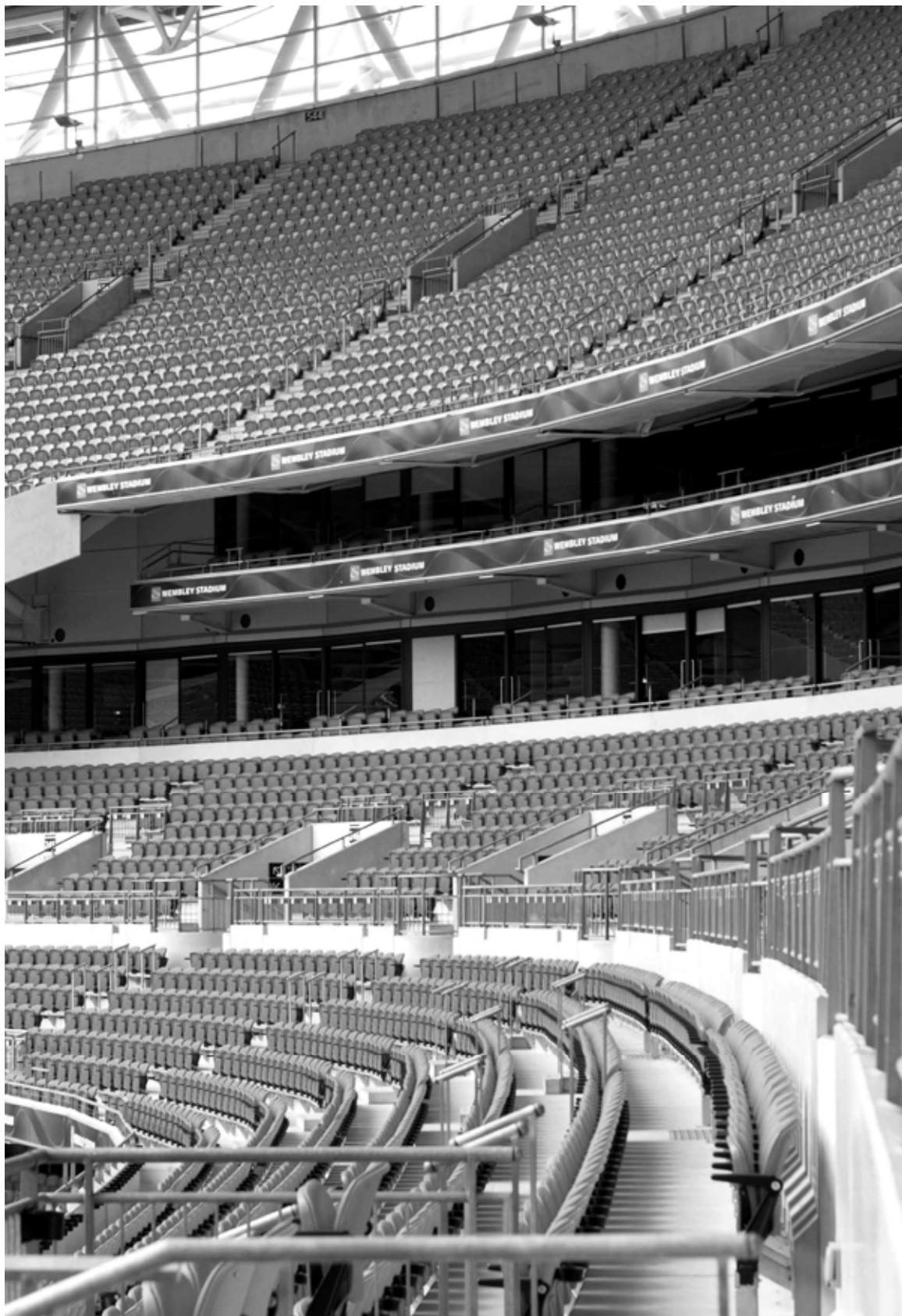
Fot. 1-29. Stadion Wembley (nowy), Londyn. Fragment widowni – przykład sposobu rozwiązania łóż dla widzów uprzywilejowanych. Kosztem miejsc trzeciego piętra powstały dwa poziomy kameralnych balkonów, dostępnych z przypisanych im indywidualnych, luksusowych pomieszczeń, stanowiących ich zaplecze. Na pierwszym planie szczegóły aranżacji siedzisk w poszczególnych rzędach widowni.
