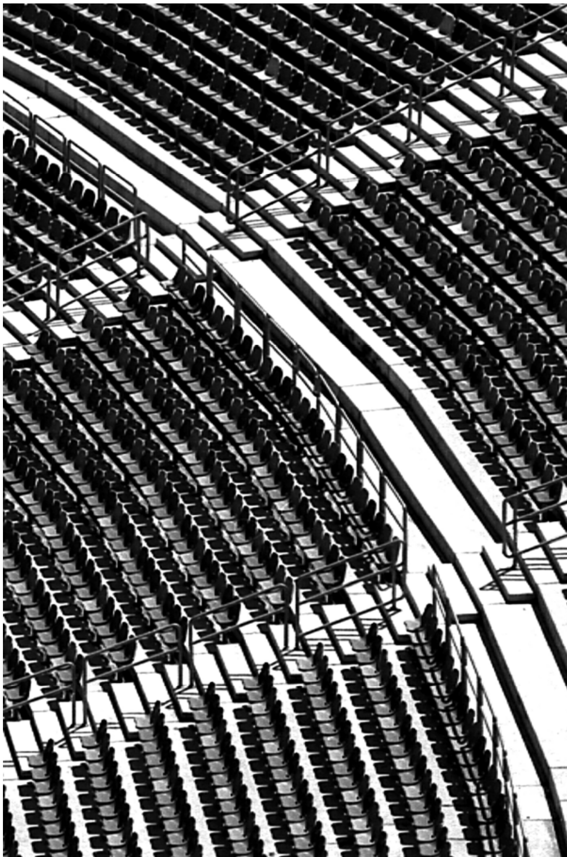
Fot. 3-5. Stadion Śląski – fragment widowni zachodniej. Przykład widowni o profilu krzywoliniowym. Każdemu rzędowi odpowiadają dwa stopnie schodów południkowych. Głębokość stopnia schodów wynosi 42,5cm, co ułatwia przechodzenie ze schodów na powierzchnię rzędu.
