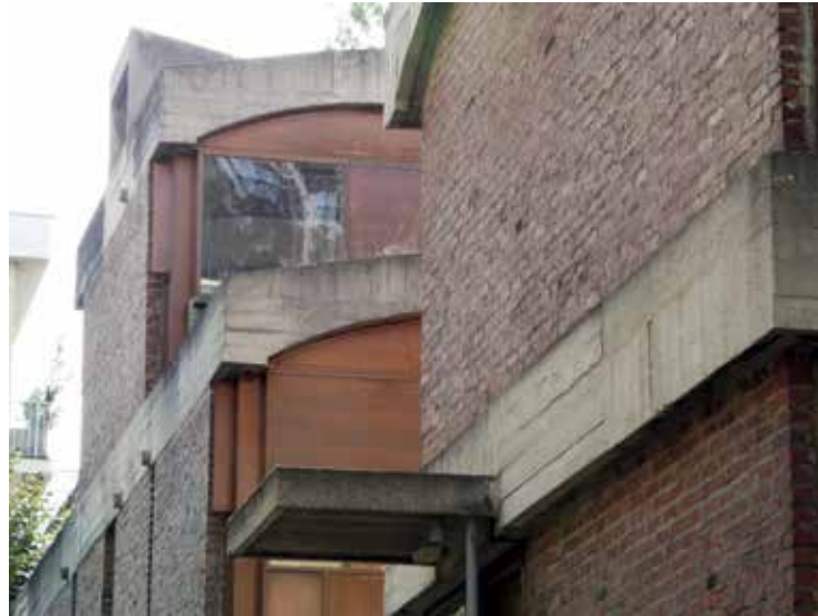
Fot. 16. Le Corbusier, Maisons Jaoul w Neuilly-sur-Seine, 1953-1955; fot. autor
