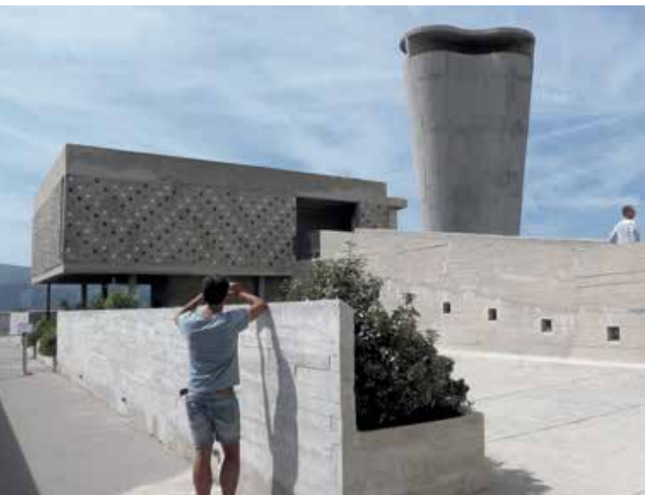
Fot. 9. Le Corbusier, Unité d'Habitation w Marsylii – dach, 1947-1952; fot. Tomasz Basista
