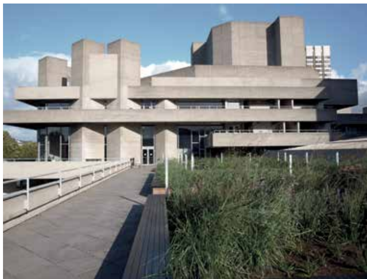
Fot. 96. Denys Lasdun, National Theatre w Londynie, 1967-1976; fot. autor
