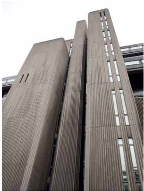
Fot. 31. Fitzroy Robinson & Partners, Sampson House w Londynie, 1976-1978; fot. autor
