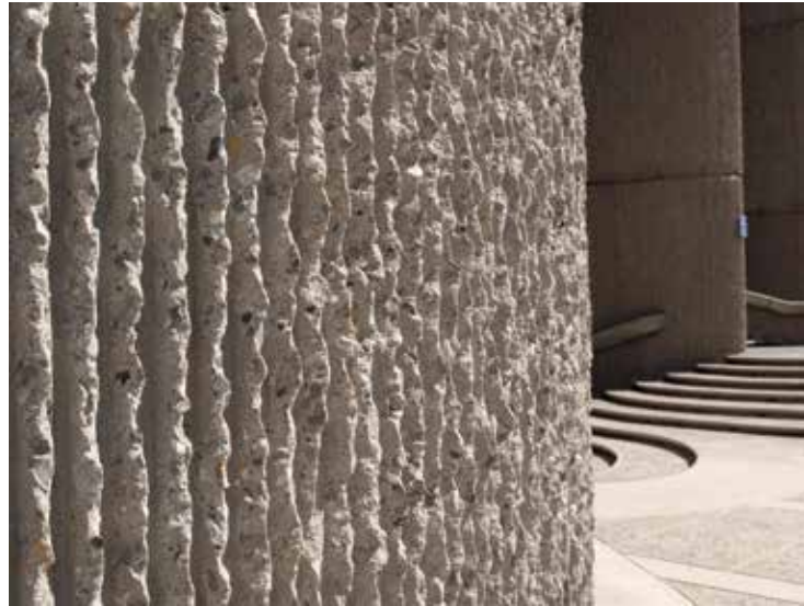
Fot. 36. Paul Rudolph, faktura budynków Boston Government Service Center, 1966-1971; fot. autor
