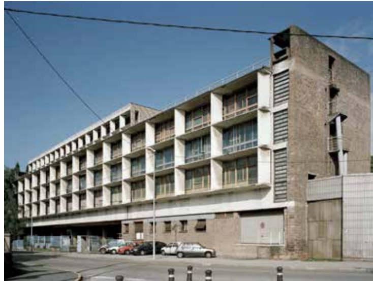
Fot. 10. Le Corbusier, fabryka Duvala w Saint-Dié, 1946-1951; fot. ©FLC/Martin Gambier
