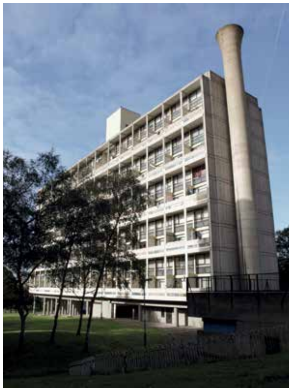
Fot. 88. London City Council Architects' Department (kier. Leslie Martin), osiedle Alton West Housing w londyńskiej dzielnicy Roehampton, 1954-1959; fot. autor
