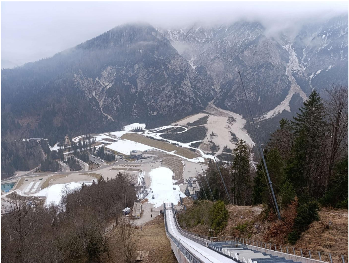
Rys. 4. Skocznia narciarska w Planicy, Słowenia.
